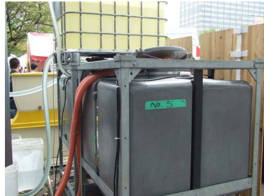
処理水タンク
