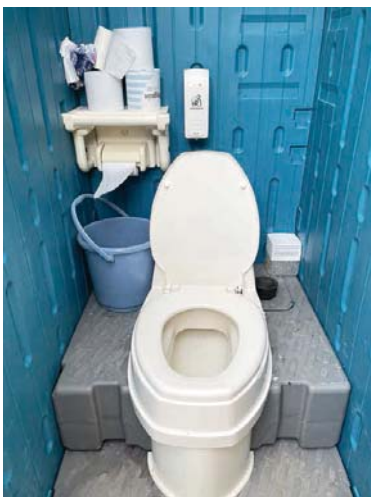
アタッチメントで洋式化した和式の仮設トイレ
