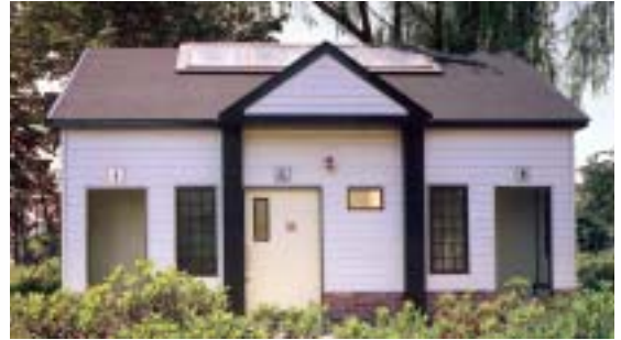
常設トイレ外観（断水時は常設トイレの便器を割って、簡易便器を設置し、汲み取り式として使用する事も可能
