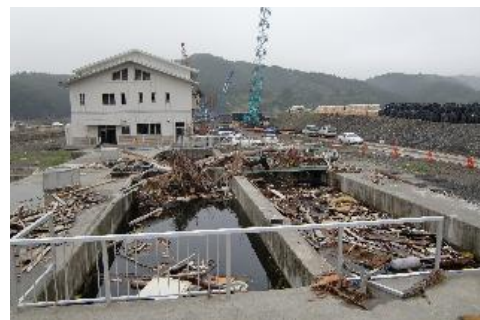
最終沈殿池と汚泥処理棟
