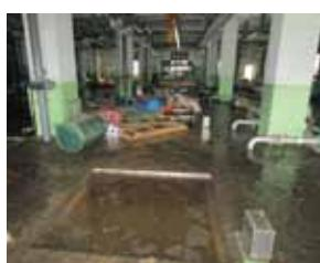
当施設での浸水は、処理棟と管理棟の1階部分で、最大で1.5mにもなった。また、処理棟の地下ポンプ室とプロワ室は水没してしまい、し尿処理場としての機能は停止してしまった。7月17日午後より一部のし尿等の受け入れを開始したが、あくまで中継槽としての役割であり、全ての工程を行うまでの復旧は出来ず、他の施設に一部の処理を委託せざるを得ない状態での稼働となつた。
